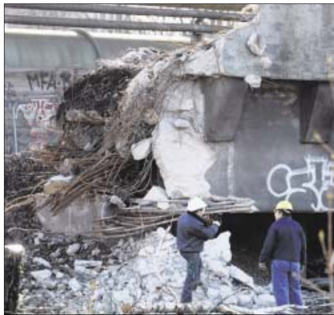
Von der Öffentlichkeit unbemerkt, hat der Rückbau der Eliasbahn-Trasse längst begonnen. Sieben Teilstücke fehlen noch.
