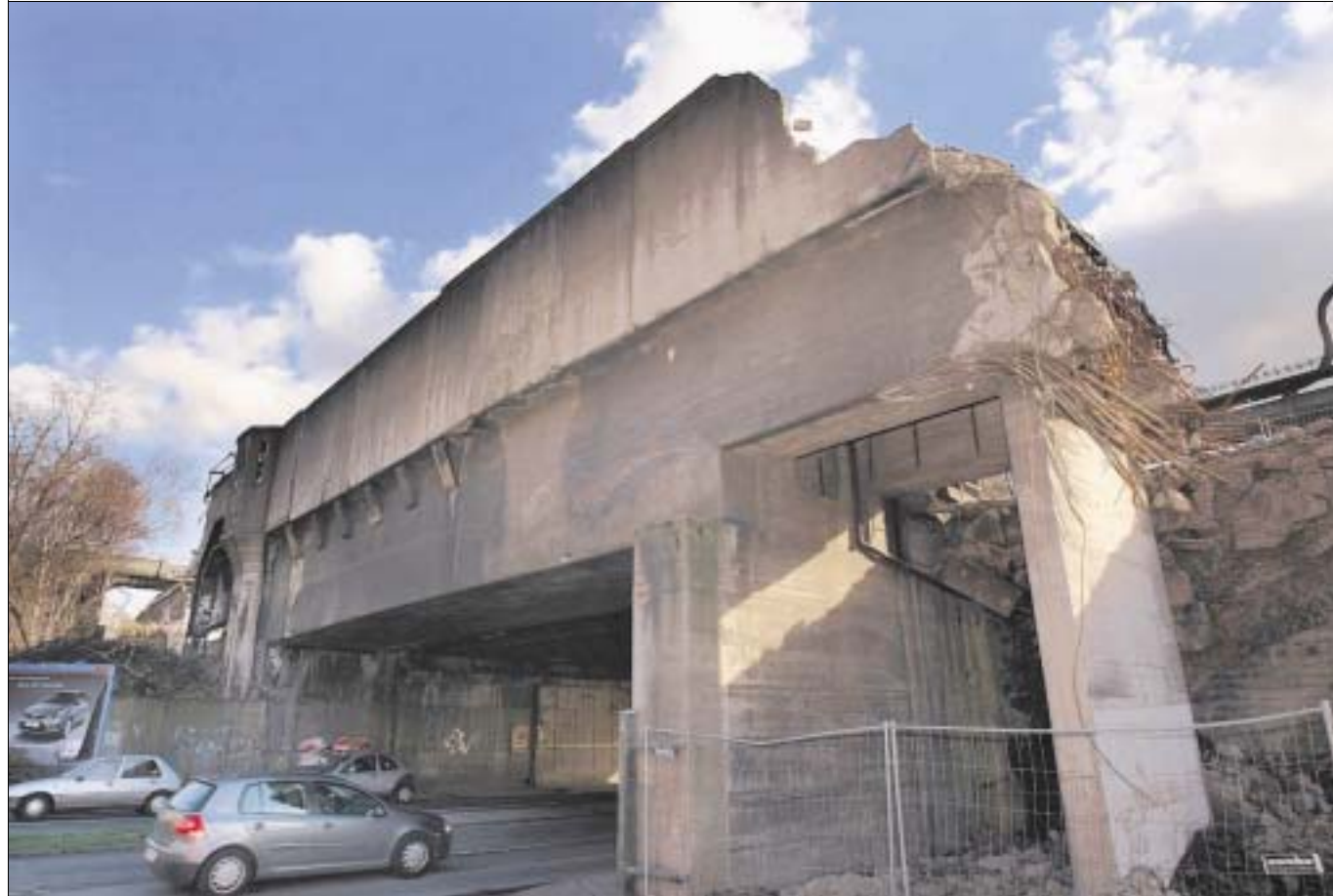
Das Brückenbauwerk über der Faßstraße in Hörde steht (noch). Die Abbrucharbeiten sollen Ende Mai beendet sein. Vor Mitte März, so ein Experte, tastet die Trägerkonstruktion aber wohl niemand an. (Bilder: Jochen Linz / PiLi)
