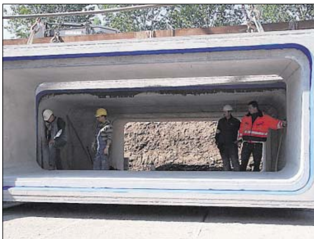
So groß wird der Durchlass unter dem Lennehochwasserdamm: 5,5 Meter breit und zwei Meter hoch ist das Betonprofil, das später unter der Erde liegen wird. Ein Baustein wiegt drei Tonnen.
