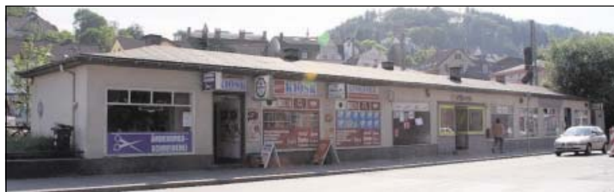
Diese Ladenzeile muss abgerissen werden, um den Busbahnhof zu verlagern. Foto: jek
