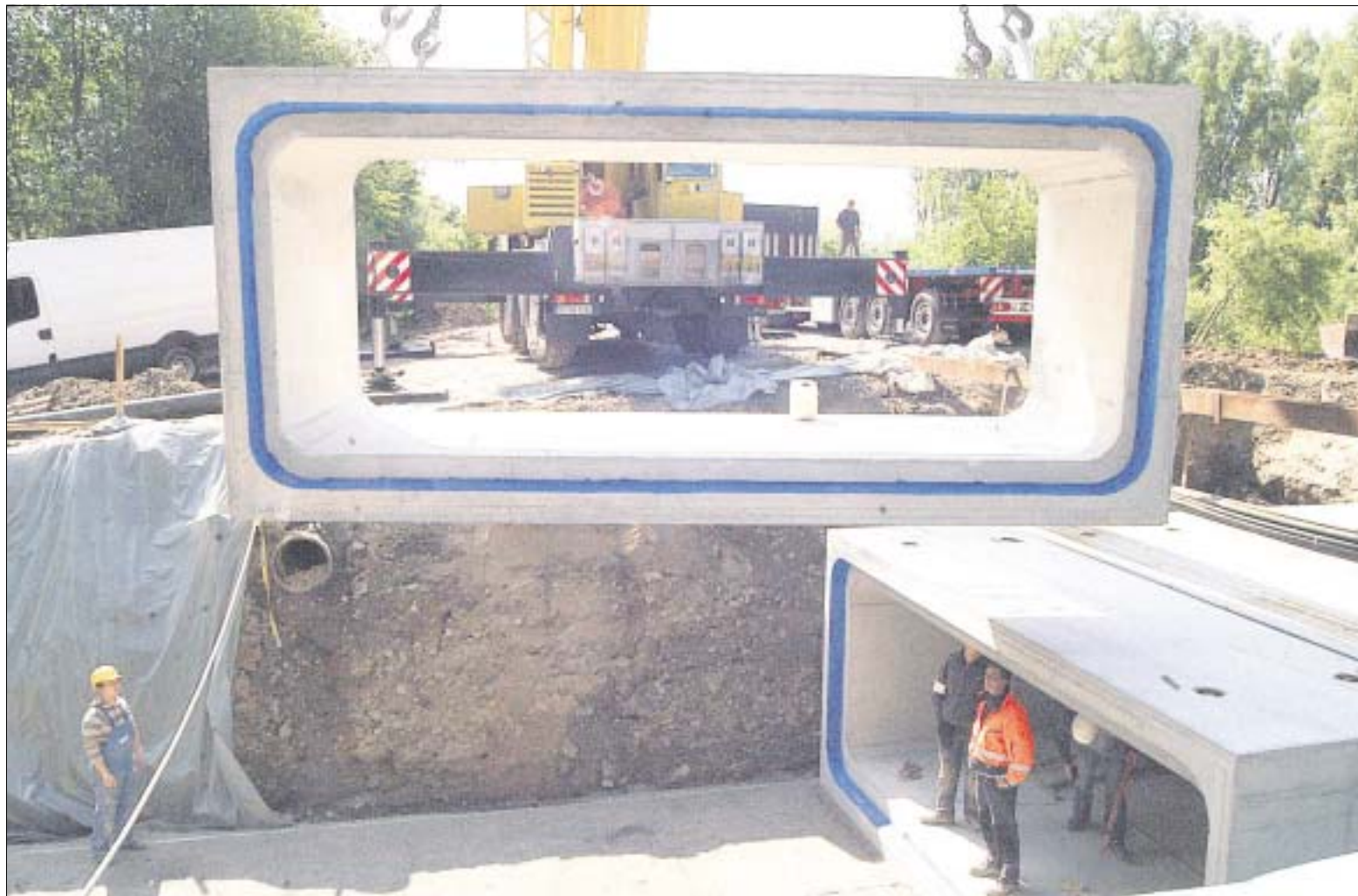
Stück für Stück wurde gestern das Betonkastenprofil für das Lenne-Überflutungsgebiet mit Hilfe eines Kranwagens zusammengefügt. Der Durchlass ist 5,50 Meter breit und 1,80 Meter hoch. Jedes der Betonstücke wiegt etwa 30 Tonnen. (WR-Bilder: Reitmajer)
